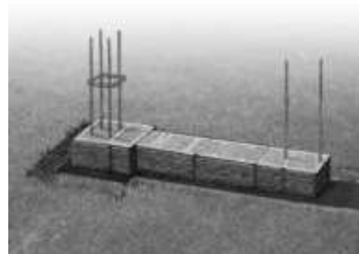
Do montażu kolejnych warstw przystępujemy po wypełnieniu betonem warstwy poprzedniej.
