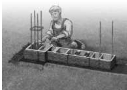
Gotową warstwę zasypujemy betonem klasy C20/25.
