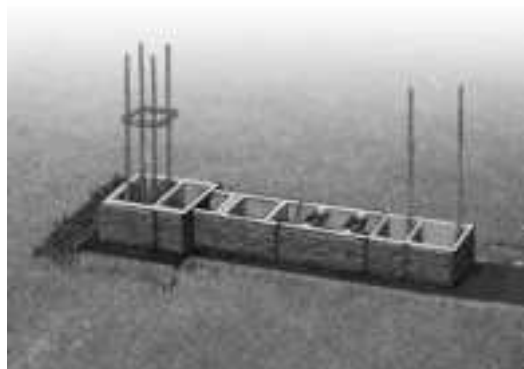
Kolejne elementy także łączymy mrozoodpornym klejem montażowym.
