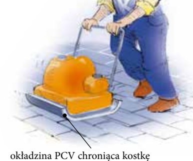
okładzina PCV chroniąca kostkę przed uszkodzeniami
